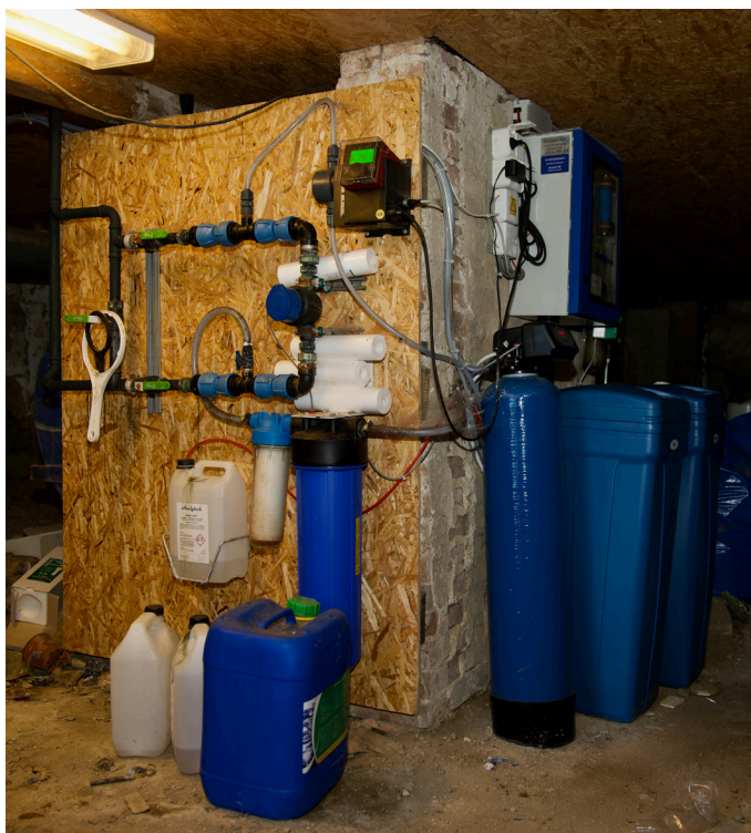
Att flexibiliteten är stor när Anolytechs system installeras bevisas av installationen på Mansdala Gård. Gårdens vattenledning kommer in under boningshuset och systemet är därmed installerat i dess källare.
