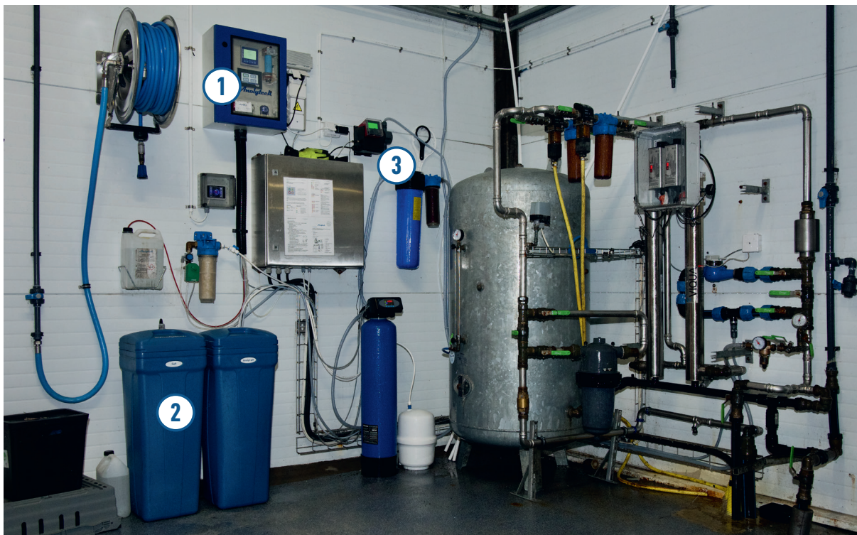
Anolytechs system som produceras AnoDes på plats består av en styrenhet monterad på väggen (1), behållare med salt (2) och en blandningsmodul (3).
